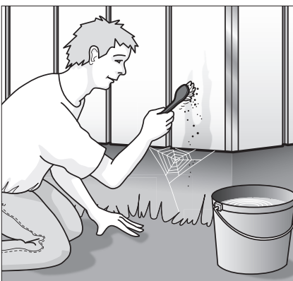
Fjern spindelvæv og smuds, og rengør med rent vand.
